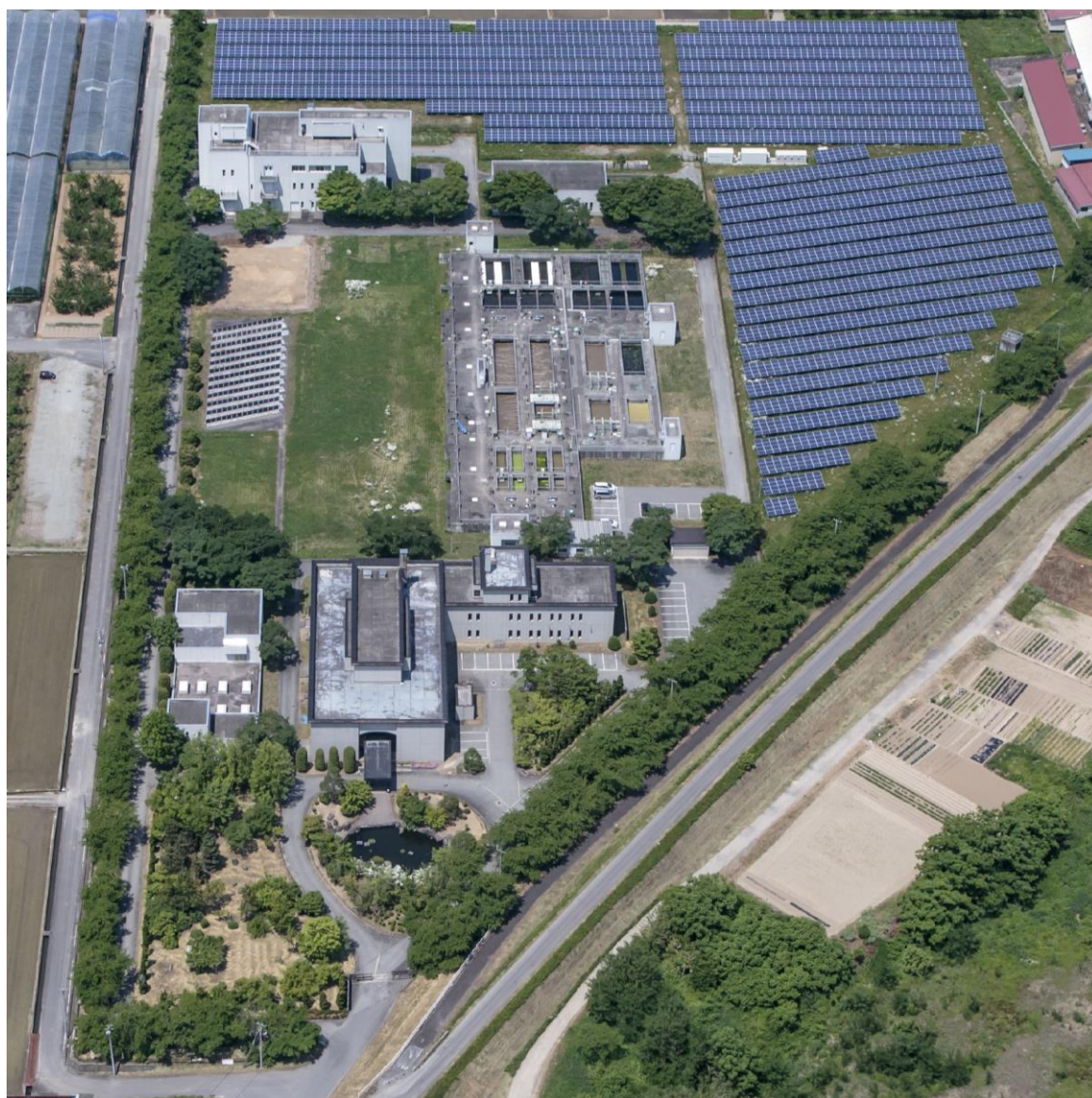
図 2-1 寒河江市浄化センター
