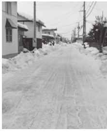
ロータリー車による巾出し後
