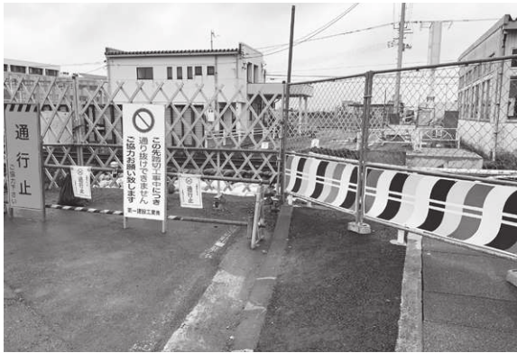
嶋踏切歩道設置工事
