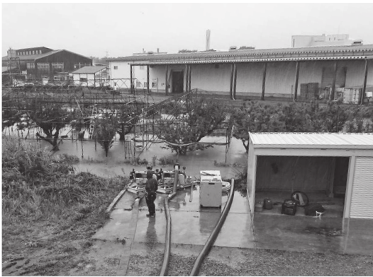
内川水門前の強制排水ポンプ設置作業
