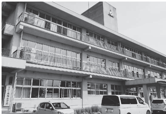
普通教室と特別支援教室にエアコンが設置された 市内の小学校、中学校（写真は南部小学校）
