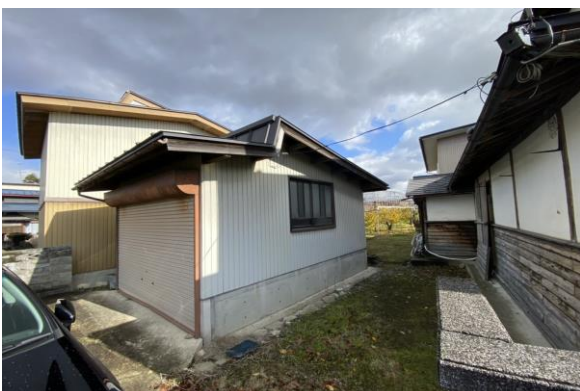
付帯小屋(外観)
