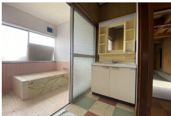
1階 浴室・洗面所
