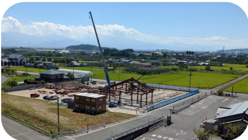
写真① 現在の工事の様子
