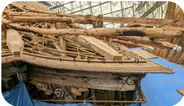
長年厚い茅を支えていた向拝(本堂正面の箇所)部分の下地
