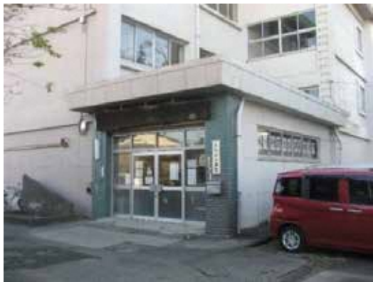
寒川町文化財学習センター(空学校利用事例)
