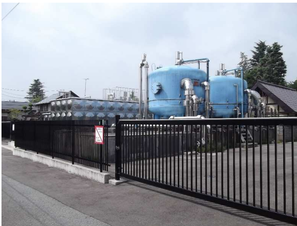
三泉ポンプ場（浄水場）
