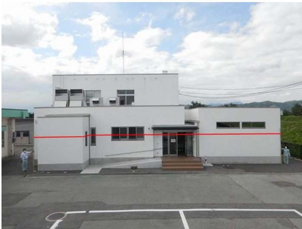
川原浄水場・ポンプ場 管理棟 浸水深H=2.7m
