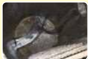
油脂で詰まった公共下水道管▼の清掃作業
