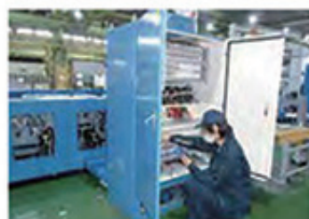
製品配電盤内の通電確認作業
