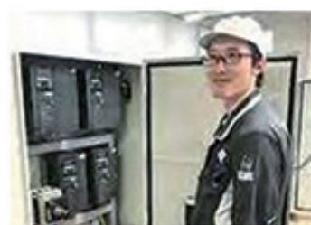
制御盤の組立
