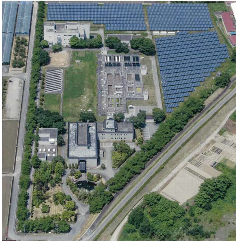
図 2-1 寒河江市浄化センター
