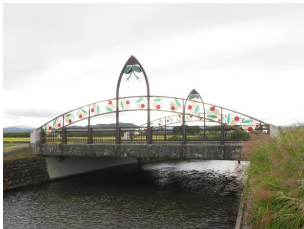
紅さやか橋（市道 石持チェリーランド線 1994 年架設）
