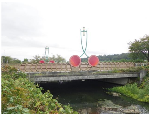
紅秀峰橋（市道 石川西洲崎線 1994 年架設）
