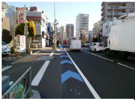
▲車道左側部の路肩内に矢羽根型の路面標示を設置した事例
