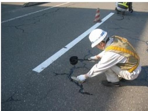
写真-5.2.1 ひびわれ注入工
