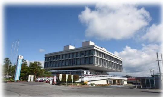
市役所庁舎（日本近代建築100選）
