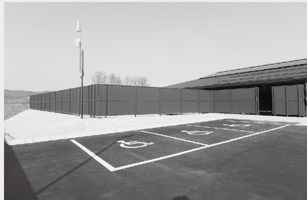
入口付近に障がい者用駐車場を設置
