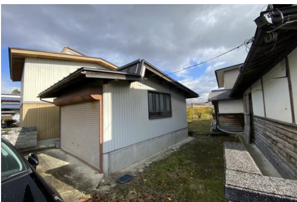
付帯小屋(外観)
