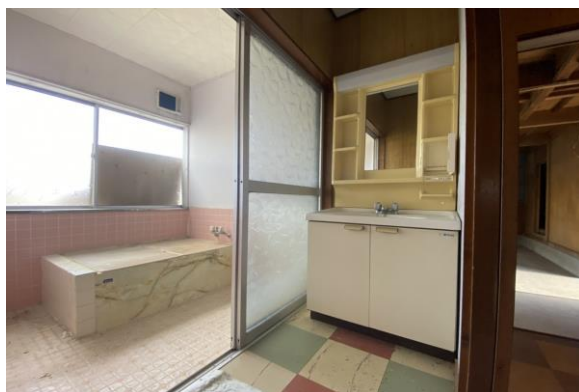
1階 浴室・洗面所
