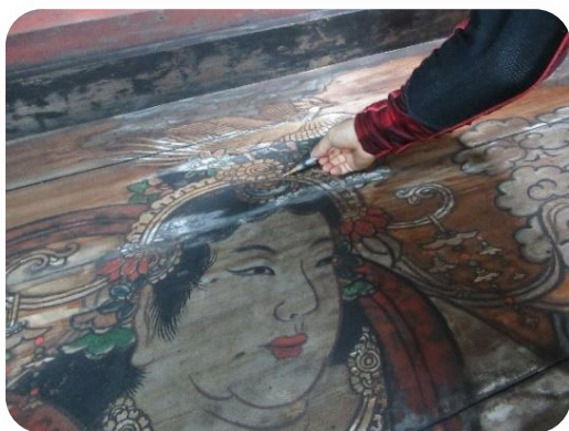
注射器を使用した膠挿し
