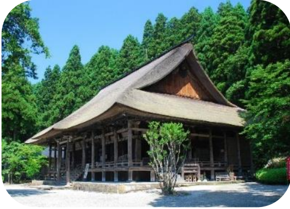
本山慈恩寺本堂 山形城主最上氏により建てられ、元和4年(1618)に竣工されました。築約400年の建造物です。
