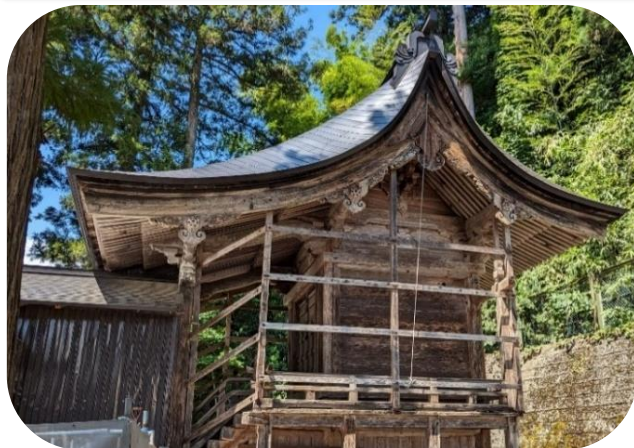
「本殿」懸魚(げぎょ)の鰭(ひれ)、木鼻(きはな)など精緻な装飾が見られています。
