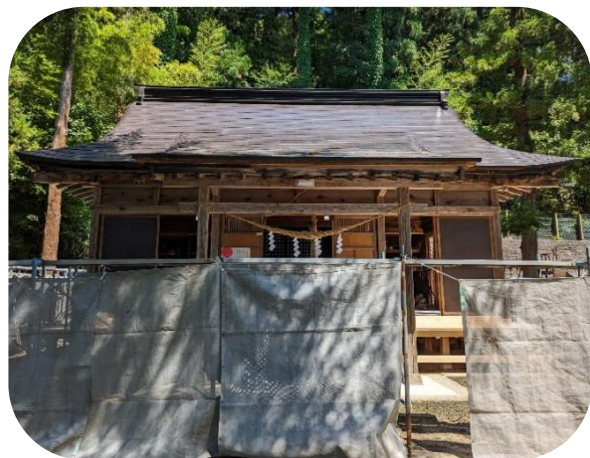
「修理工事中の拝殿」現在は仮囲いがされています。
