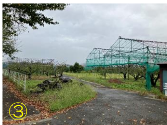
③ 区画内南側に通っている市道石川鹿島線
