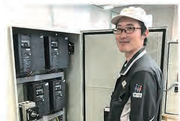
制御盤の組立
