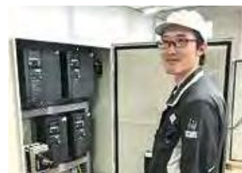
制御盤の組立
