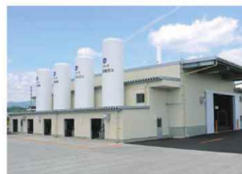
充填工場外観
