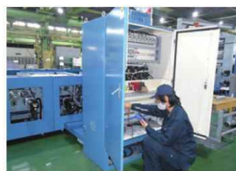
製品配電盤内の通電確認作業
