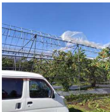
ビニールハウスの修復
