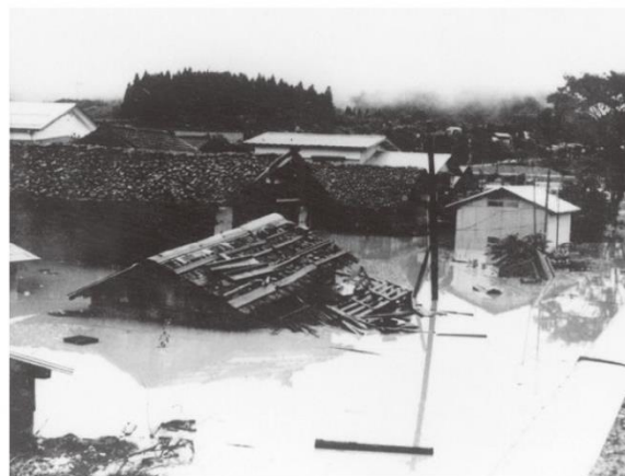
戸沢村・濁流と水位上昇により浸水した家屋
