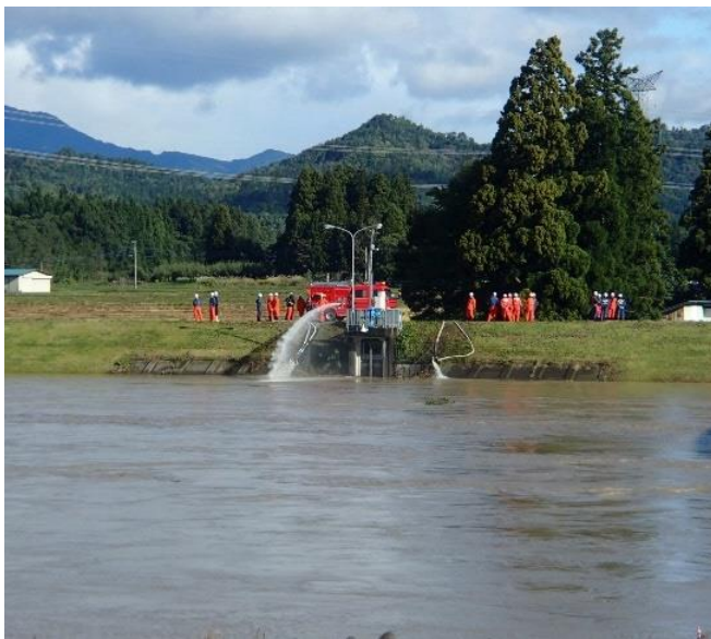
最上川 県道248号上伊佐沢川西線松川橋下流 (185.7k付近) 排水作業状況
