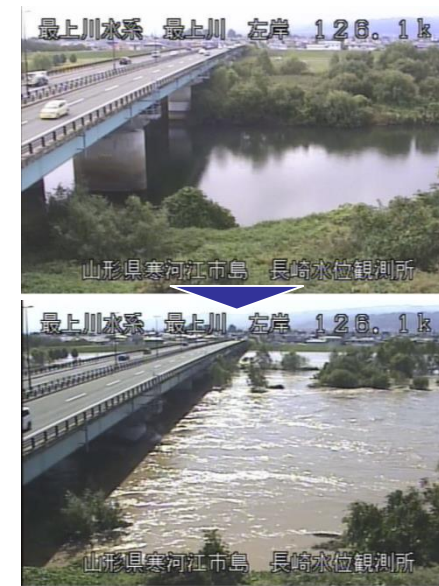
最上川 国道112号長崎大橋 上流(126.1k付近)
