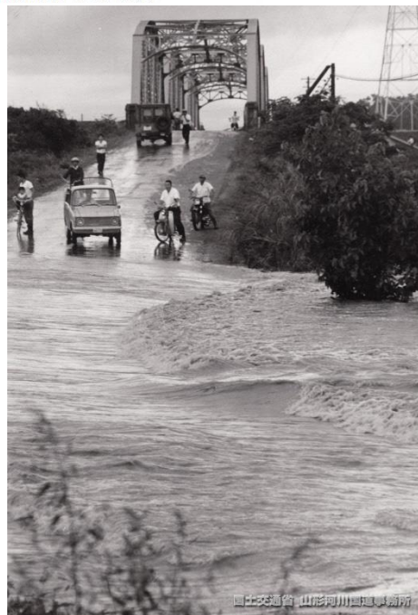
中山町・国道112号の越水
