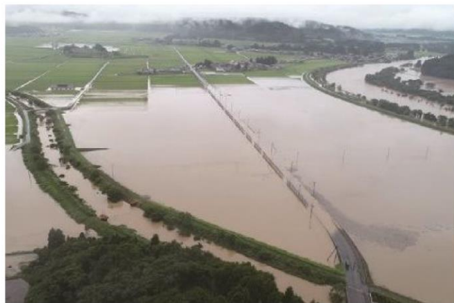
鮭川氾濫により水田が広範囲にわたり冠水
