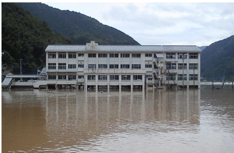
平成26年8月 避難所2階の浸水 (徳島県)
