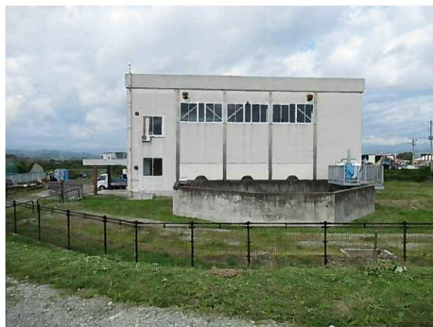
沼川排水機場
