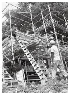
解体中の舟着観音堂
