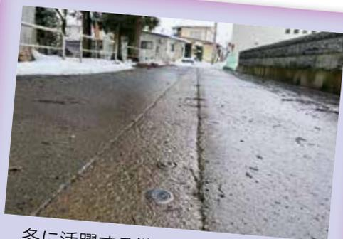
冬に活躍する消雪パイプ。道路に埋め込んだパイプから路面へ地下水を散布し、除雪・融雪・路面凍結防止をする装置です。昭和30年代に考案され、主に東北・北陸・山陰地方で導入されています。夏場に打ち水として利用する県もあるそうですよ！（中島弘人）
