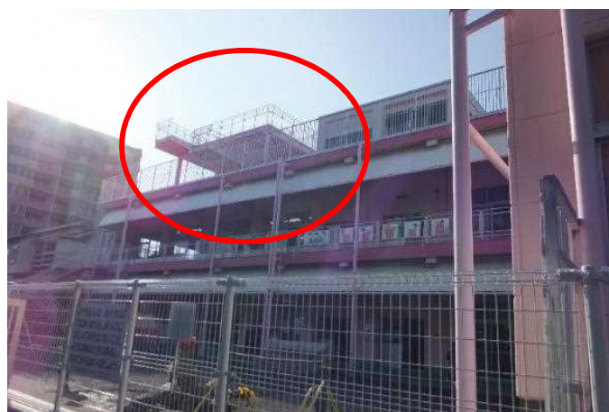
図 15 屋上への避難場所を増築した事例
